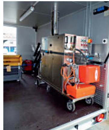
Ausbau mit dem Dampf-Erzeuger ST-150...
