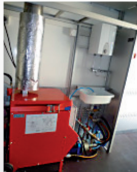
Ausbau mit der mobilen Diesel-Heizanlage THERMOBOX TH-70 und sanitäre Einrichtung...
