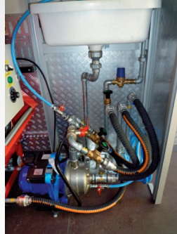
Wasserpumpe für die mobile Diesel-Heizanlage THERMOBOX TH-70 komplett verrohrt im Fahrzeug...
