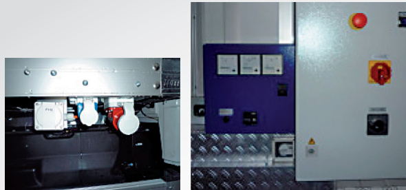
Externer Anschluss und Umschalter Strom-Generator...
