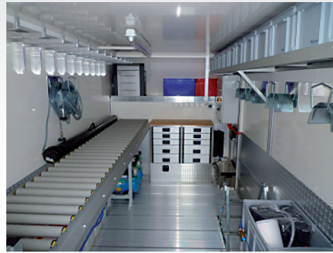
Ausbau zu Hausanschluss-Lineranlage für städtischen Betrieb...
